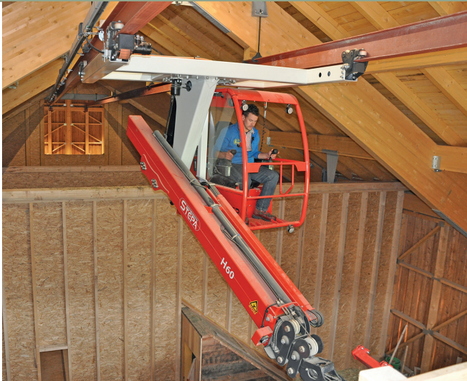
DER HALLENKRAN VON STEPA ist der Drehpunkt in der freitragenden Heubergehalle.
