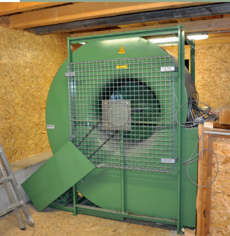
IN ZWEI HEUBOXEN erfolgt die Heutrocknung mittels Dachabsaugung und der Trocknungstechnik der Firma Lasco.
